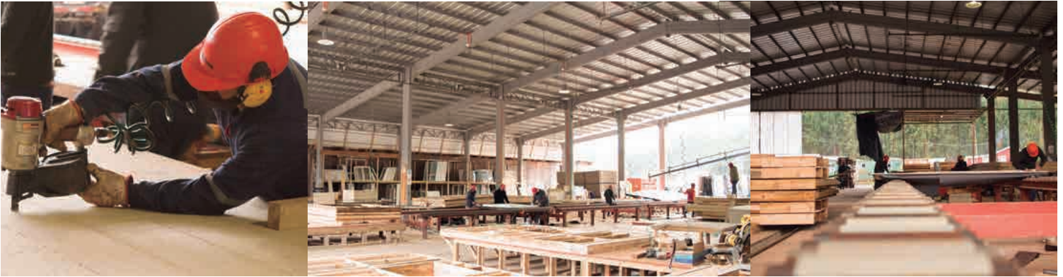
Figuras 2, 3 y 4. Planta de fabricación Nueva San José
