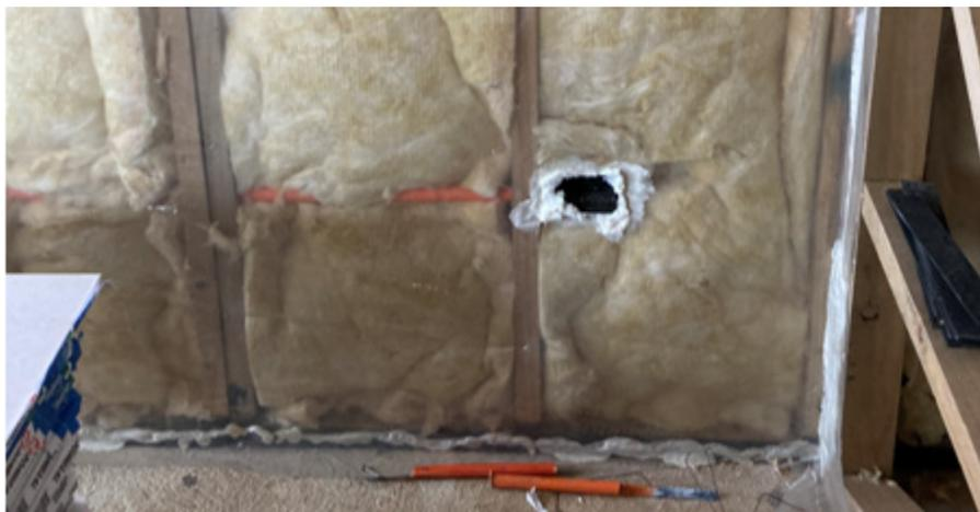
Figura 27: caja de enchufe en muro perimetral. Porvenir II, Osorno.
