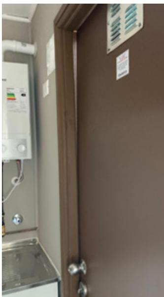
Figura 65: deformación de puerta genera apertura en la parte superior, Pillanlelún, Lautaro.
