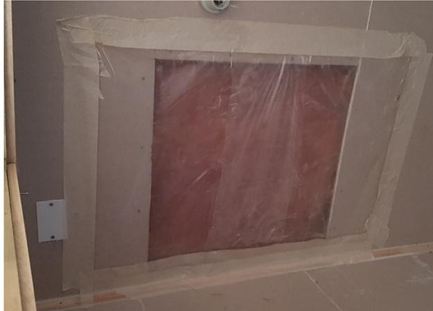
Figura 59: Elementos del Lote 08, sellados con polietileno y cinta adhesiva. Porvenir II, Osorno.
