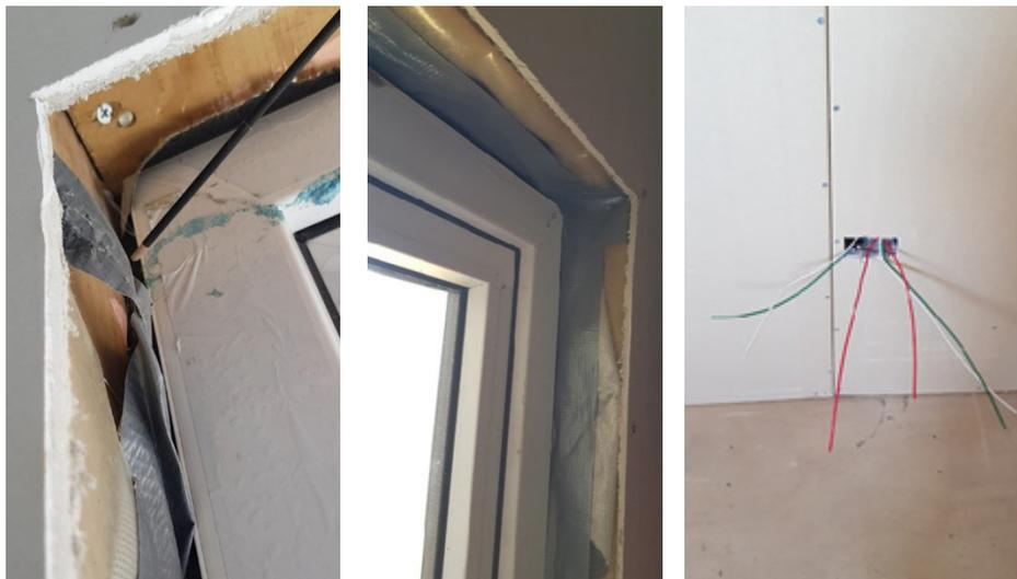
Figura 60: a) cinta adhesiva mal instalada en el encuentro con la ventana, b) ventanas sin sobre marco, c.1) ausencia de cajas y tapas eléctricas, c.2) ausencia de sellos en los encuentros de las placas de yeso cartón.
