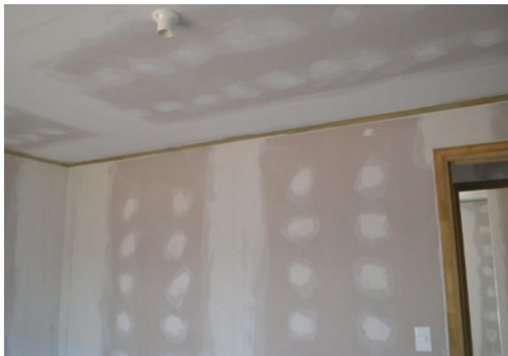
Figura 44: unión entre paneles, Foliico, Los Lagos.
